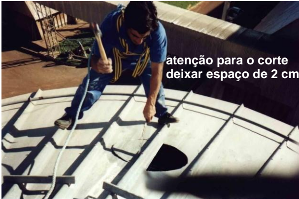
Corte em círculo na cobertura
